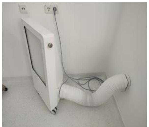
Die Frischluft kann direkt von außen angesaugt werden mit Kernbohrung in der Wand oder durch das Fenster. Die Luft wird dann mittels Hepa H 14 Filter von Partikel, Bakterien und Viren durch Operio Clinic gefiltert und versorgt den OP-Raum/ Eingriffsraum mit ultrareiner Frischluft und erzeugt gleichzeitig einen Überdruck im OP / Eingriffsraum . An der Außenseite kann ein Wetterschutzgitter angebracht werden zum Vorreinigen der Luft und zum Schutz vor Insekten und Regen.
