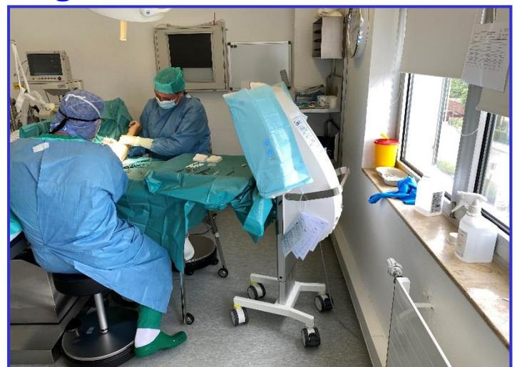
**Handchirurgie:** der sterile Air Flow schützt sowohl die Instrumente als auch das OP-Feld. Man erreicht eine extrem hohe Asepsis da der sterile Air Flow weder durch das OP-Team noch durch OP-Leuchten behindert wird. Der sterile Air Flow wird vom Personal als sehr angenehm empfunden, da es keine Kaltluft erzeugt.
