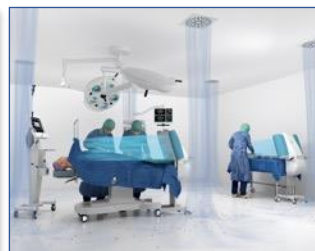
Sala Operatoria Classe ISO 5 con TOUL – Flusso laminare
